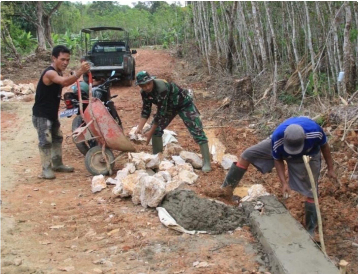
Pembuatan Badan Jalan Sepanjang 1020 meter Capai 45 Persen
