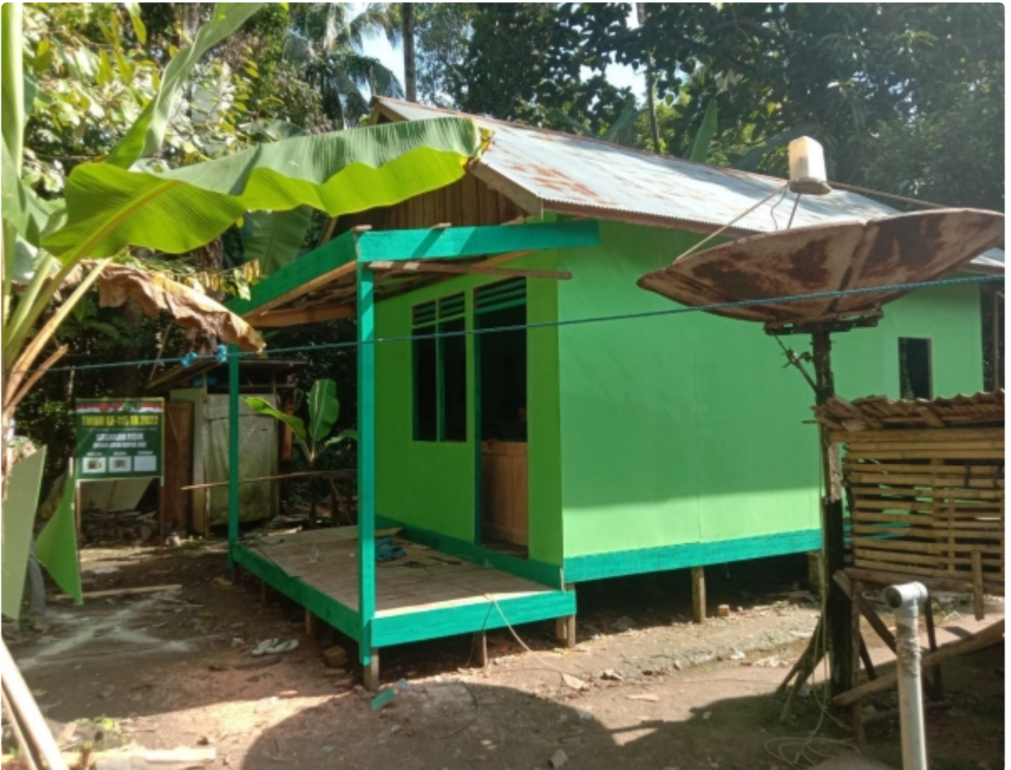
Satgas TMMD Sudah Selesaikan Bangunan dan Cat Rumah Bapak Ade
